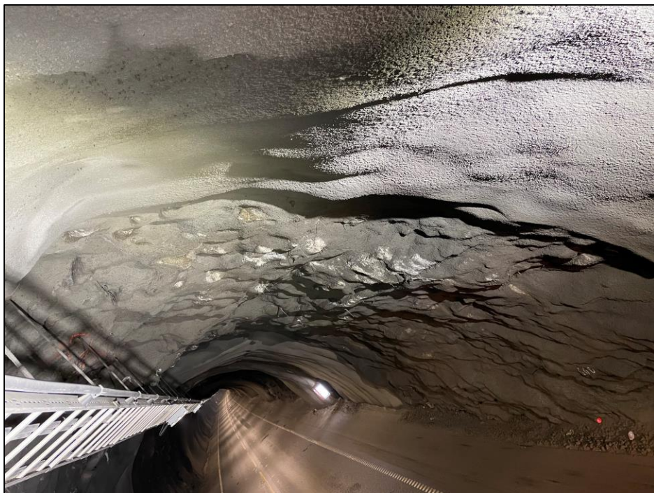
Foto 3. Eksempel på kalkutfelling i tunnelen.
