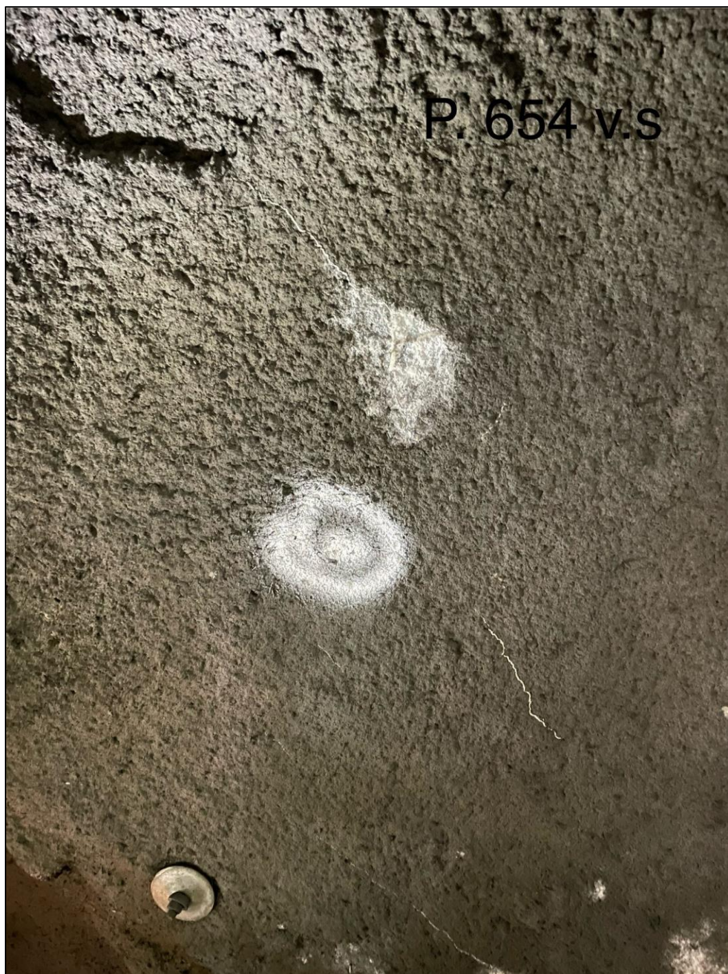
Foto 6. Pel 654 v. side: bom i sprøytebetong.
