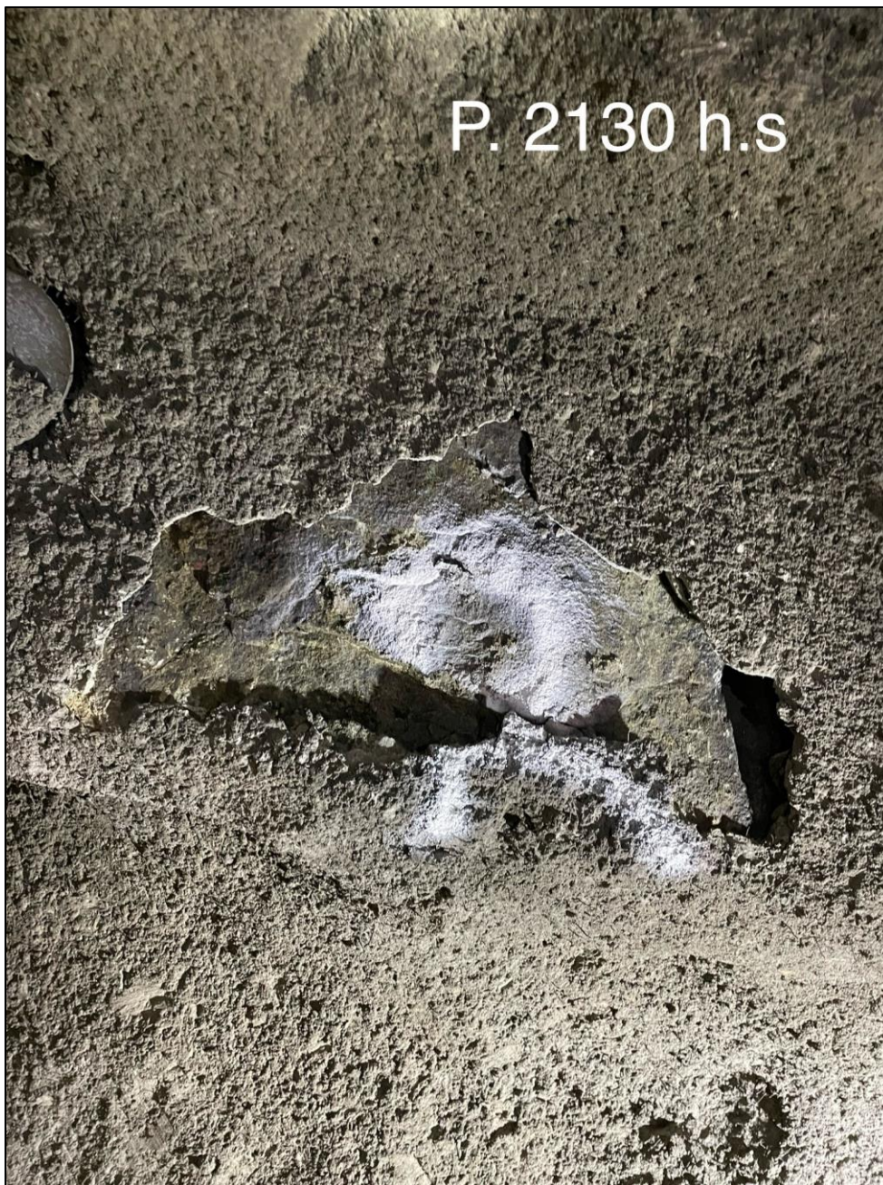
Foto 13. Pel 2130 h. side: løs sprøytebetong, må renskes og påføres ny sprøytebetong.
