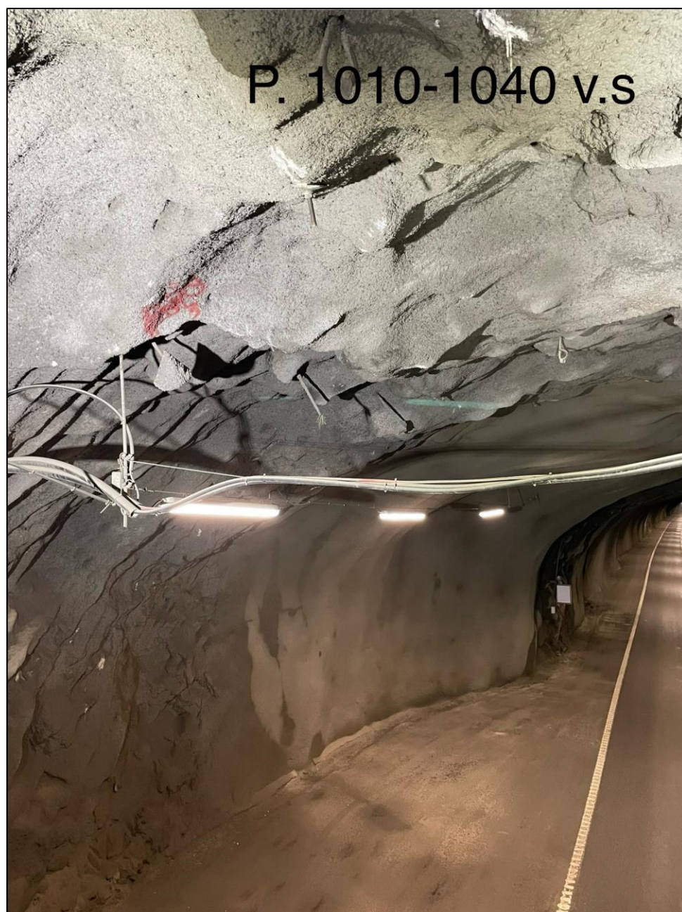
Foto 7. Pel 1010-1040 nisje v. side: Eksempel på vrakbolter.
