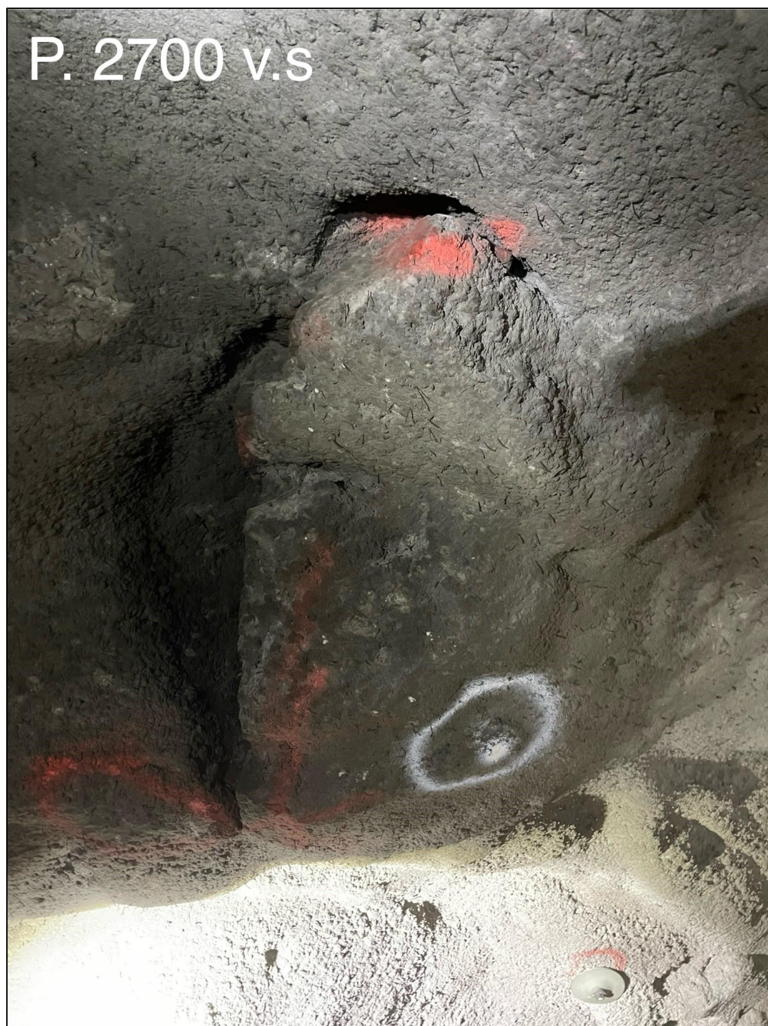
Foto 17. Pel 2700 v. side, avløst blokk henger delvis i sprøytebetong, sikres med ny 2,4 m lang bolt.
