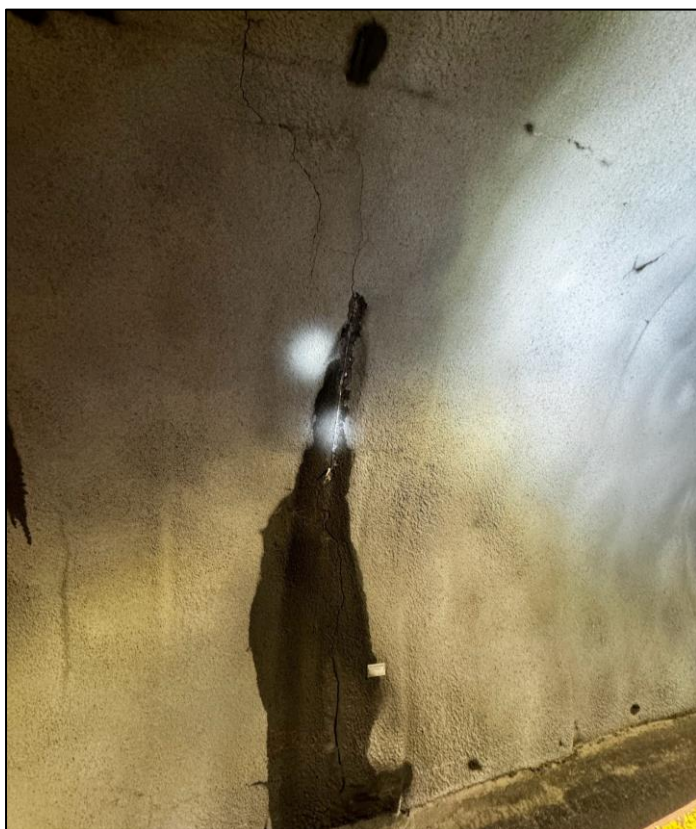
Foto 4. Pel 220 v. side: Eksempel på riss i brannsikret PE som anbefales å fuges.
