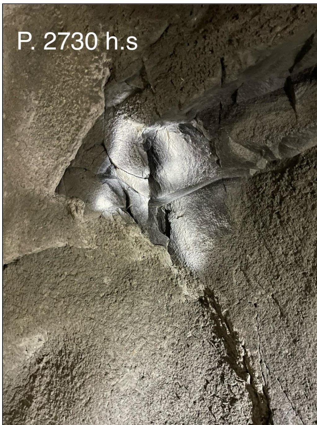
Foto 18. Pel 2730 h. side Bart berg i sprøytebetong. Må renskes og tilføres ny sprøytebetong.
