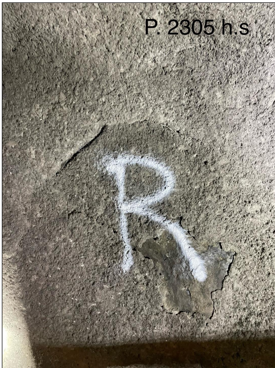
Foto 14. Pel 2305 h. side: bom i sprøytebetong, må renskes, påføres ny sprøytebetong og ev. suppleres med bolt.
