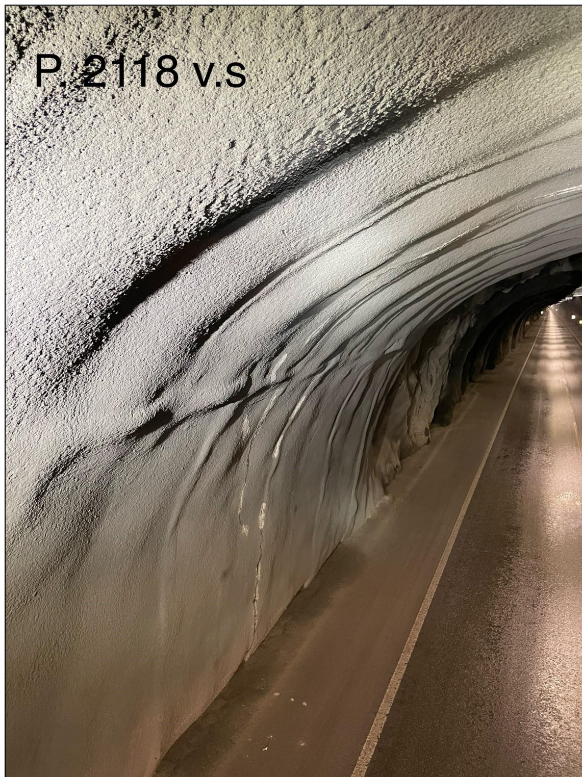
Foto 12. Pel 2118 v. side: sprekk i brannsikret PE-skum.
