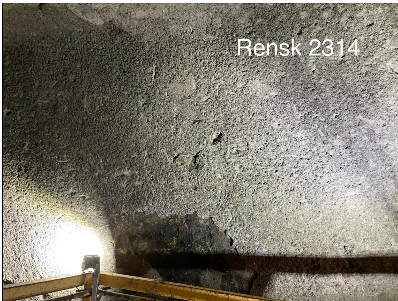
Foto 15. Pel 2314: bom i sprøytebetong, må renskes, påføres ny sprøytebetong og ev. suppleres med bolt.
